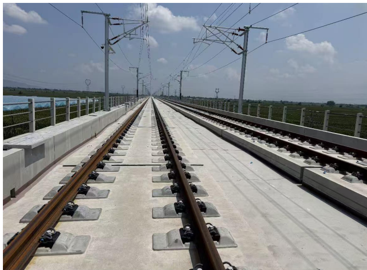
公司轨道扣件产品应用场景示意图 (雄忻高铁建设现场情况)
