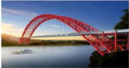
图例：四川犍为岷江特大桥
