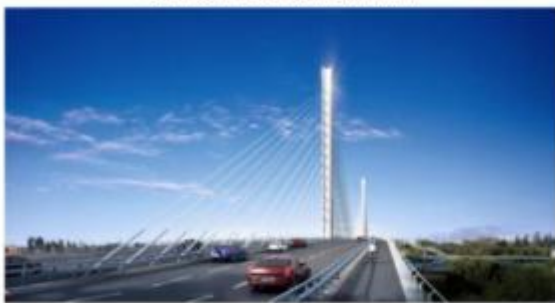
图例：上海泖港大桥
