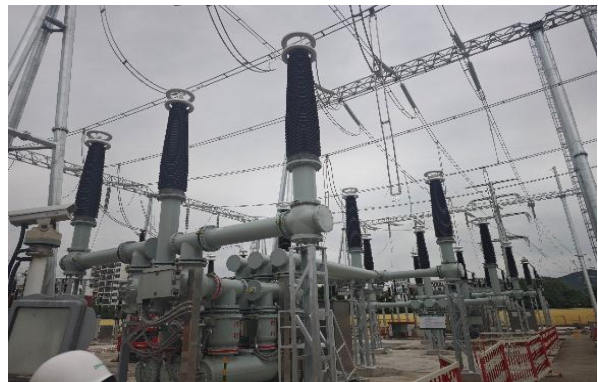
220kV 马家磅变电站工程
