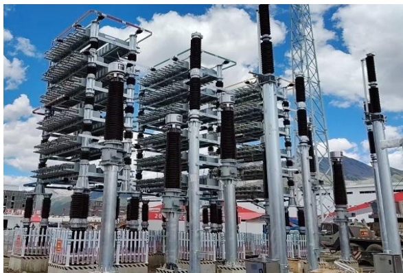
阿坝-成都东 1000kV 特高压交流工程
