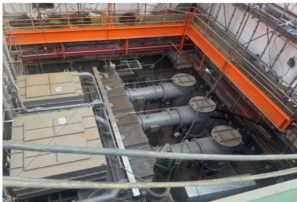
蓬勃油田群岸电应用工程海上 EPP 平台项目
