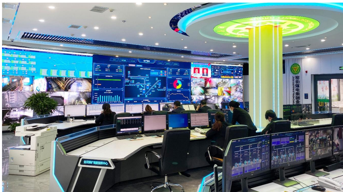
图示：公司某智慧矿山项目综合管理平台集控中心与调度信息中心
