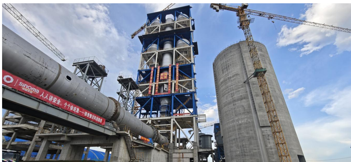
图示：柬埔寨桔井水泥总包项目窑尾预热器塔架封顶
