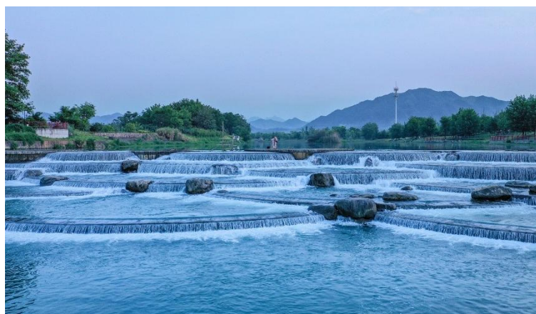
永定河综合提升工程
