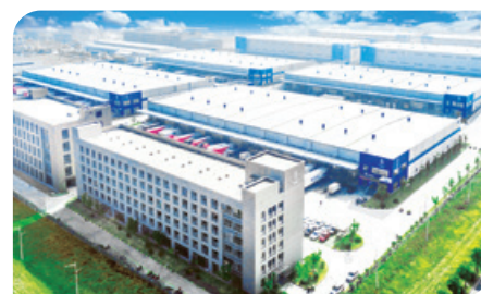
深國際物流港（杭州一期）
