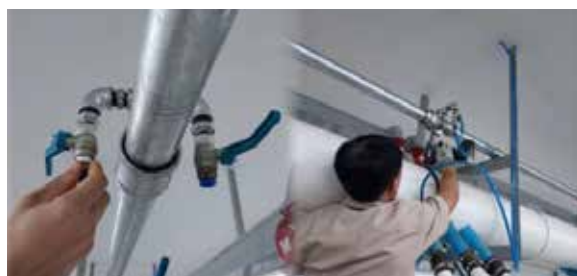
■ 我們已更換生產線上破損的氣喉接頭，以消除壓縮空氣洩漏、減少能源損耗及延長設備壽命。
