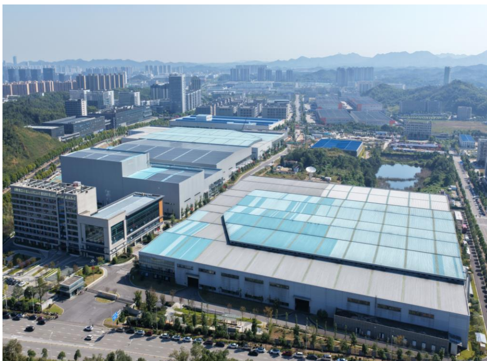
航空产业园航拍图
