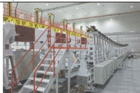
柔性装配系统
