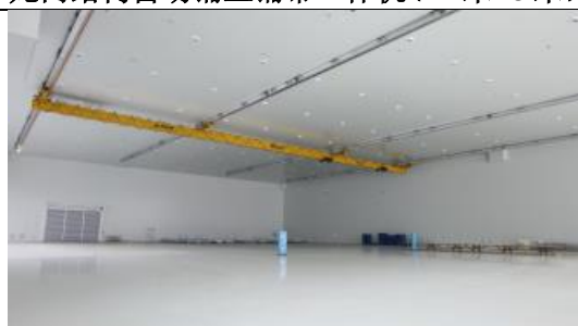
铺丝机洁净间（8700 平方米）
