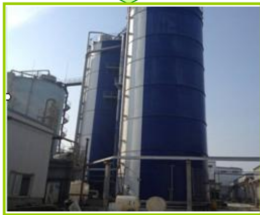
图 6-8 厌氧塔施工建成
