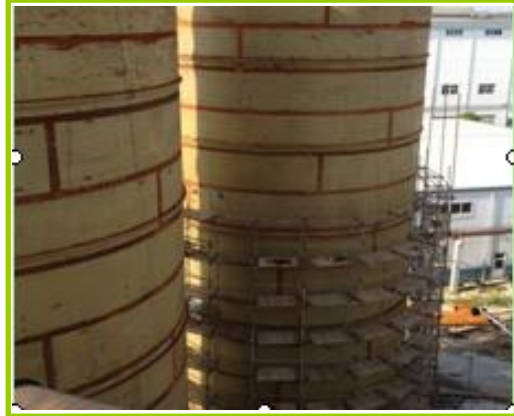
图 6-7 厌氧塔施工中
