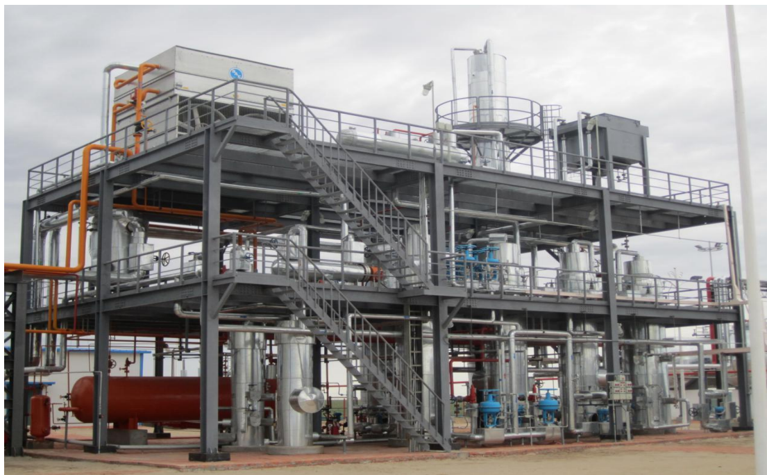
大庆油田三次采油二氧化碳驱工程项目现场照片
