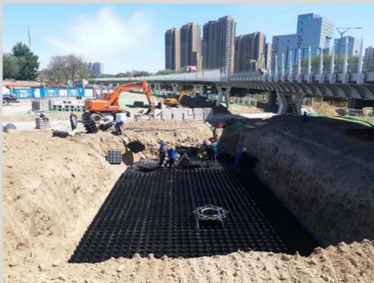
PP 蓄水池模块安装现场
