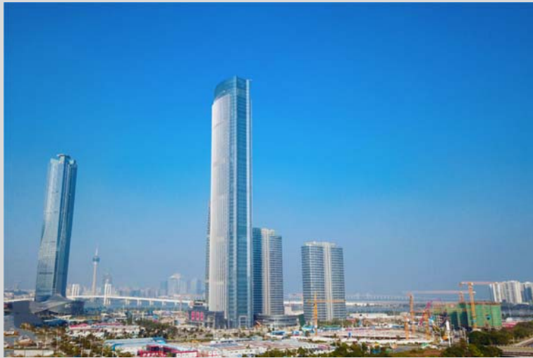
横琴广场竣工
