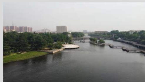
墨水河综合整治工程
