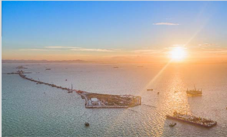
6 月 17 日，深中通道首节沉管完成浮运安装
