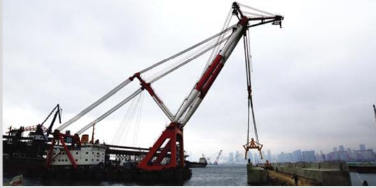
2月28日，大连湾海底隧道项目复工复产
