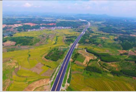
广西河池至都安高速公路工程
