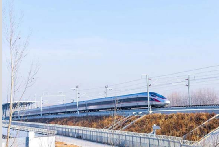
京雄城际铁路
