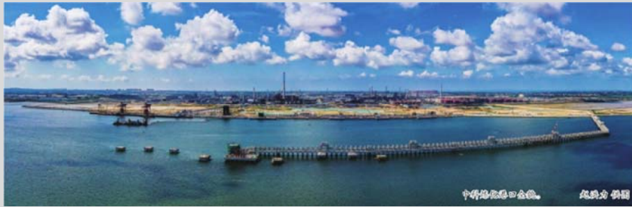
国内最大石化港口——中国石化中科炼化港口全面建成投用
