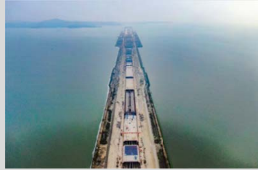
国内最长水下隧道——太湖隧道实现全部陆岛通道转换
