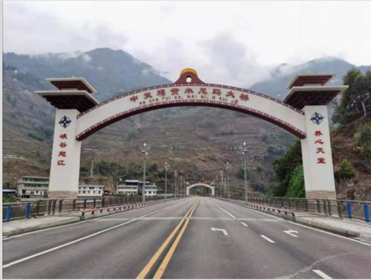
10月18日，中交福贡木尼玛大桥主体工程完工
