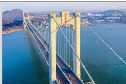
世界首座高速铁路悬索桥——五峰山 长江大桥正式开通
