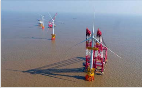
国电舟山普陀 6 号海上风电场 2 区工程
