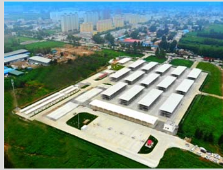
雄安新区首个城市交换中心立体停车 楼项目竣工验收
