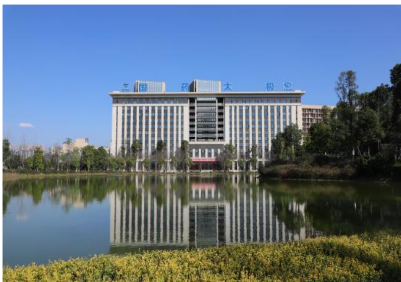
太极集团总部办公大楼
