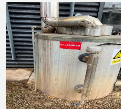
通过锅炉加热的水蒸汽加热冷水并重新导回锅炉进行热回收，实现更有效率并且节能的锅炉加热
