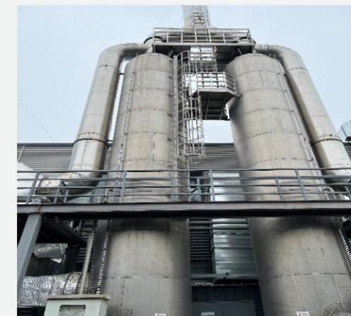
B4NMP 为阳极材料加工时产生的液体废液，有一定毒性与刺激性但可以收集进行重复利用，扬州派能通过此系统收集加工后产生稀释 B4NMP，并委托第三方进行回收利用
