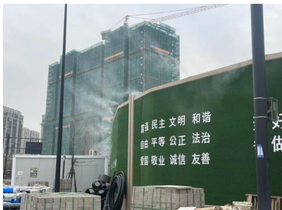
图：项目现场降尘喷淋
