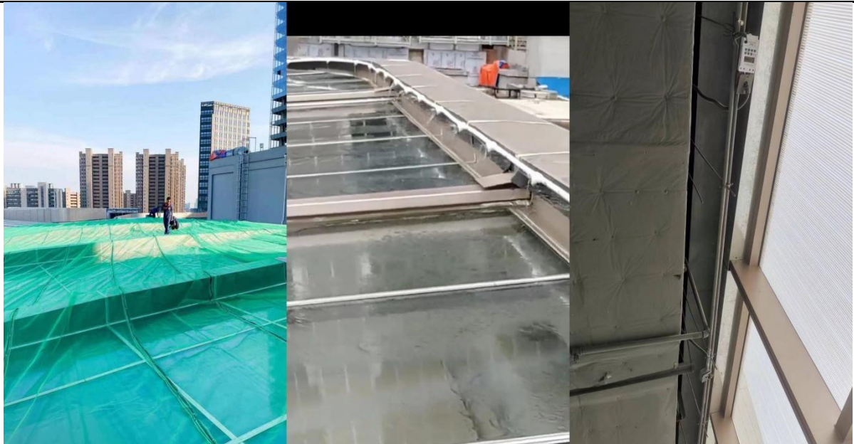
图：采光顶节能改造
