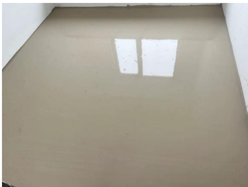
图：金地佛山西海项目应用石膏自流平地面工艺
