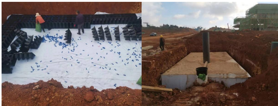
图：项目雨水收集再利用系统
