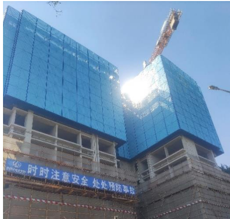
图：金地东莞松山湖项目应用铝模+爬架+全砼外墙建造体系
