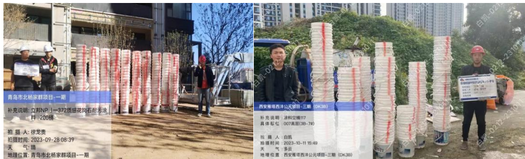
图:在建项目现场材料检查
