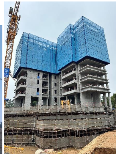
图：金地东莞松山湖项目应用铝模+爬架+全砼外墙建造体系
