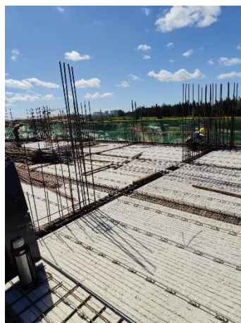
图：项目应用预制叠合楼板、预制混凝土空心条板
