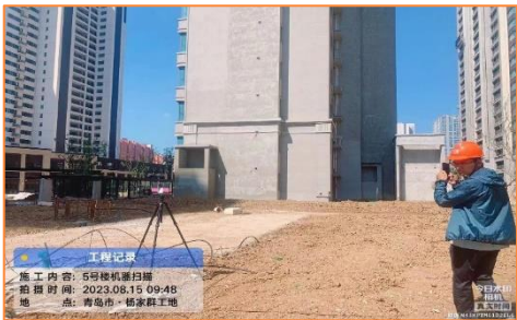
图：外墙实测机器人
