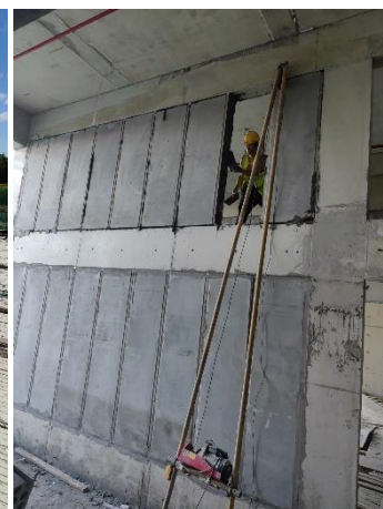
图：项目应用预制叠合楼板、预制混凝土空心条板
