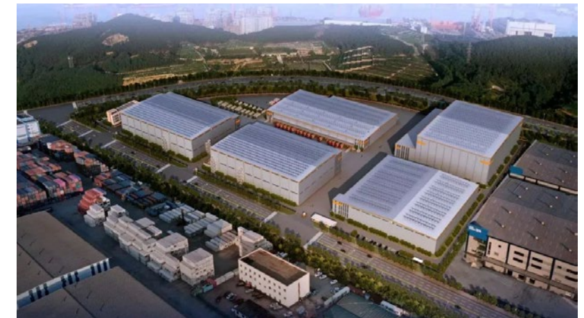
万纬青岛前湾港冷链园区
