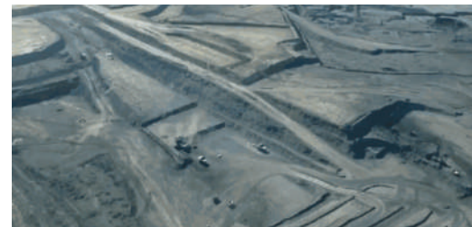
蒙古矿山一体化项目建设现场
