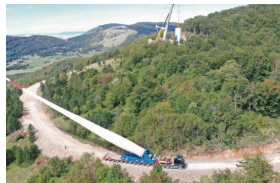
大型叶片举升装置
