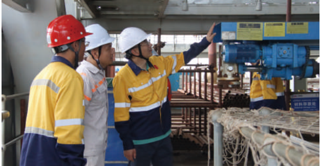
单钧总经理现场检查孟加拉博杜阿卡利超临界燃煤电站项目
