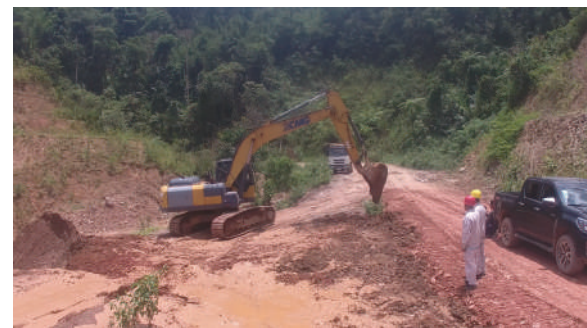
老挝南湃水电站项目抢修被灾害损坏的周边道路
