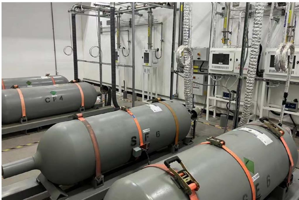
京东方北京第 5 代 TFT-LCD 生产线六氟化硫供气间正常供应气体，气瓶有固定的措施，现场设置紧急排风装置等安全措施
