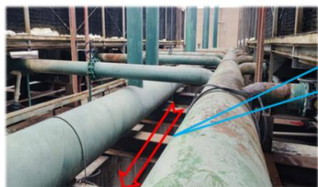
增加400mm管道从末端水塔供水到2#90K增压泵处并入原600mm管道
