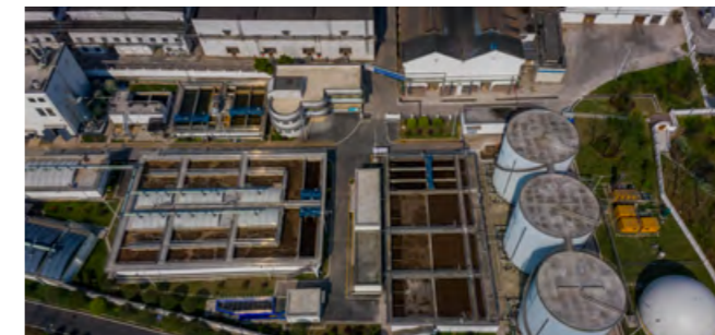
罗汉酿酒生态园废水处理站
