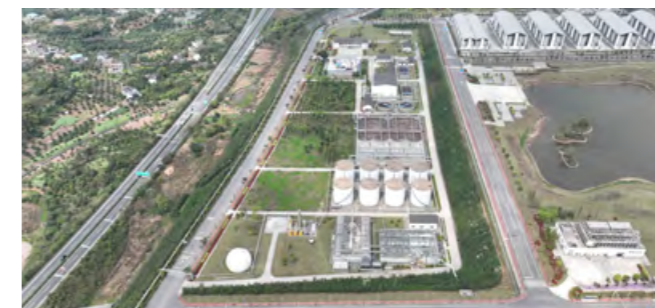
黄舣酿酒生态园废水处理站
