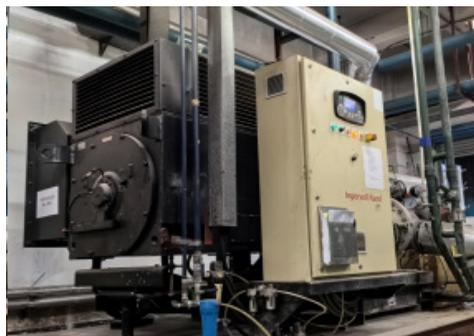
空调系统节能。采用余热热水及高压微雾代替传统电加热器热水蒸汽加湿，改造后效率提升 90%，年节电超 152 万度，碳减排 886 吨 CO<sub>2</sub> 当量；
