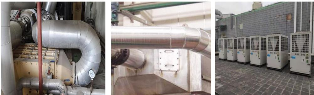
设备泵浦变频调压节能。将原设备泵浦阀门手动调节压力改造为变频器降频调压，降低过压爆管安全风险及节电 20% 以上，共完成 46 台泵浦变频改造，实现年节电 91 万度，碳减排 530 吨 CO<sub>2</sub> 当量；
