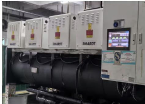
空压系统节能。将老式螺杆空压机替换为 10KV 高压离心空压机，效率提升 20% 以上，实现系统年节电 228 万度，年减碳 1,324 吨 CO<sub>2</sub> 当量；
