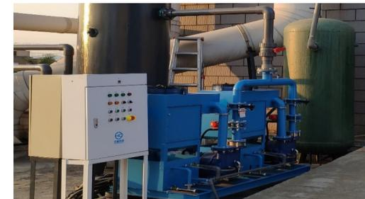
隧道烤箱利用热泵节能。将烤箱电加热器替换为冷凝器，利用热泵供热换热，实现年节电 31 万度，碳减排 178 吨 CO<sub>2</sub> 当量；
