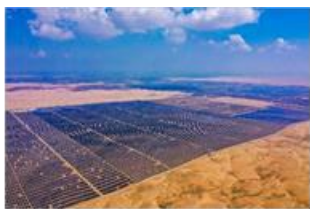
集中式光伏电站
