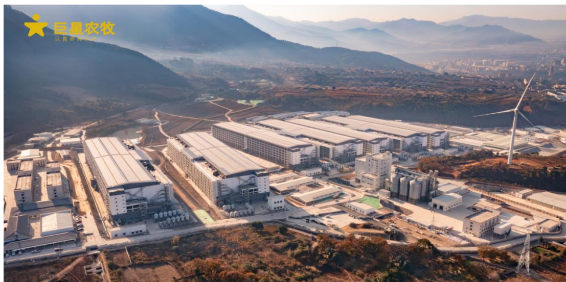
图 1：巨星农牧现代化楼房猪场
