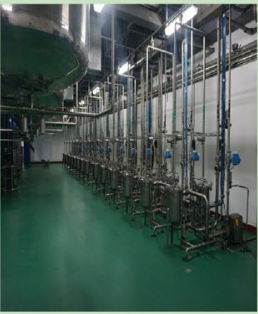
▲ 车间含醇尾液综合利用项目
