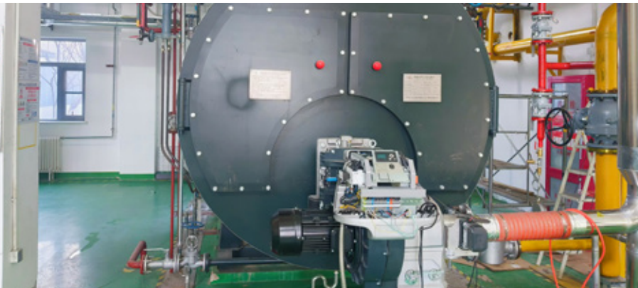
针对旧锅炉进行升级改造，将燃烧效率提升至 98%
