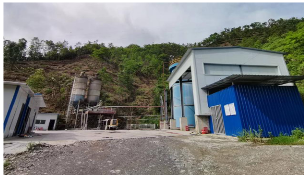
井下充填制备站，减少固废排放
