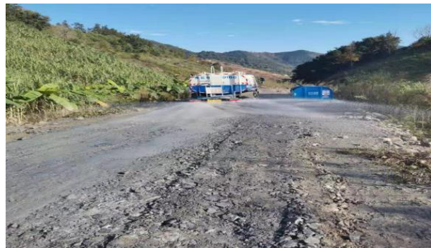
对尾矿库进库路进行洒水降尘
