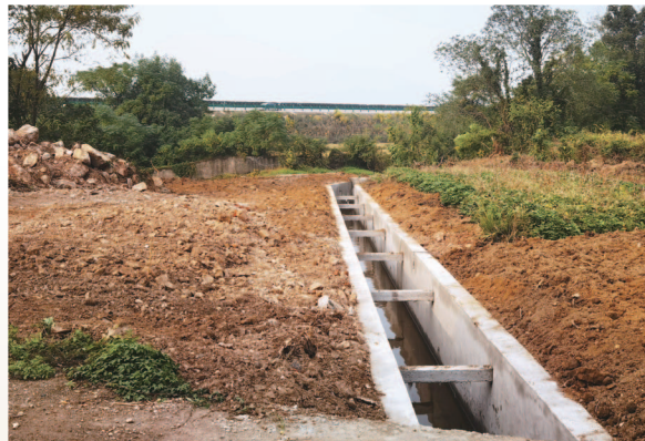
幫嚴橋鎮平定村修繕水泥溝渠
