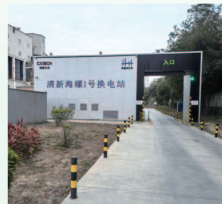
新能源換電站
