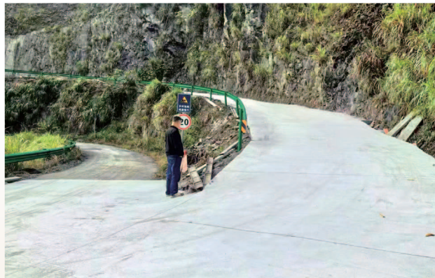
對王人鎮阜渦路進行水泥硬化處理
