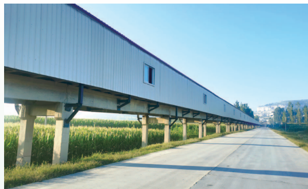
封閉輸送廊道
