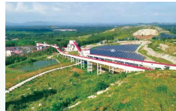
封閉破碎站、廊道
