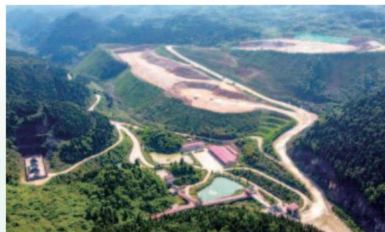
梁平海螺水泥礦山
