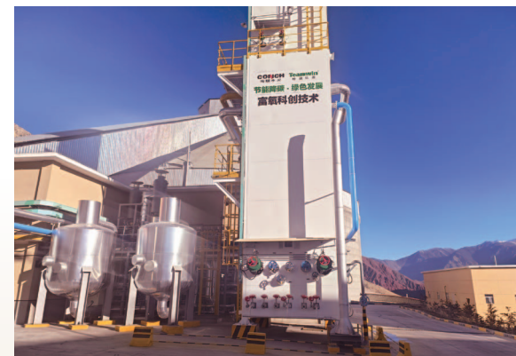
富氧燃燒改造項目
