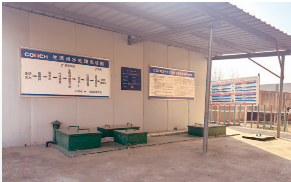
生活污水處理站
