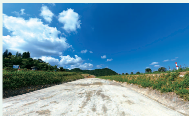
修築水穩道路
