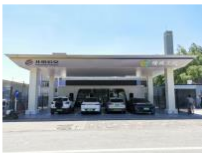
图注：木樨园超级充电站
