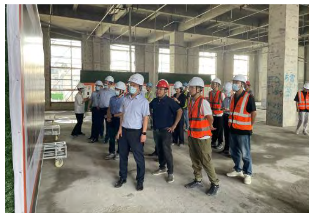
行领导对在工地进行安全检查
