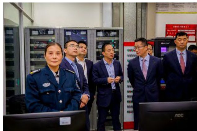
检查消控中心
