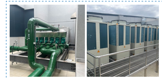
全热回收型风冷（热泵）系统
