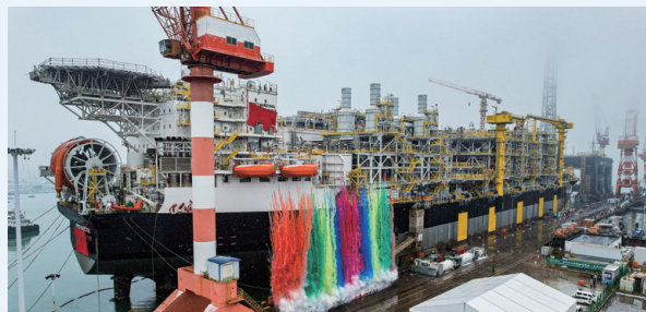
▲ Mero 3 FPSO项目
