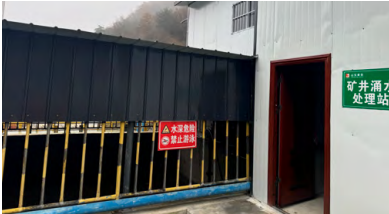
西和中宝矿井涌水处理站
