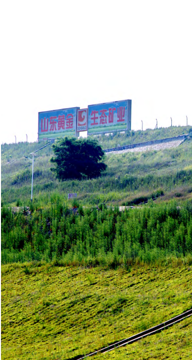
三山岛金矿尾矿库治理
