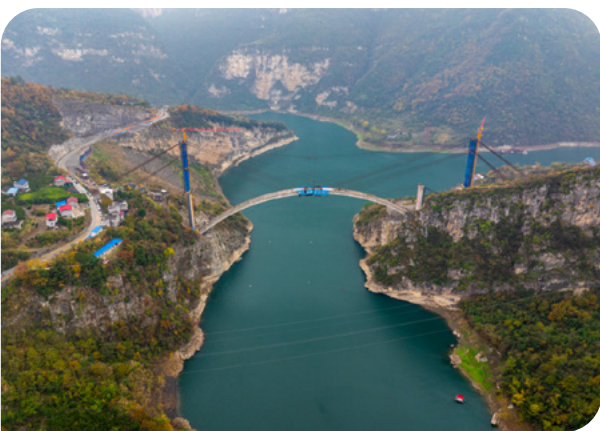
二公院设计的世界最大跨径不同拱轴系数非对称悬浇拱桥拱圈合龙
