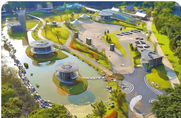
2024年度全球卓越项目管理大奖（银奖）（基础设施超大型/大型类别）——深圳市洪湖水质净化厂一期工程“深圳荷水文化科普基地”
