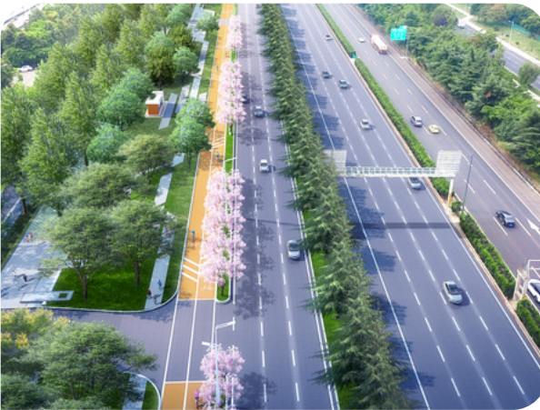
西南院四川成都综保C区城市轴线工程已完成竣工验收
