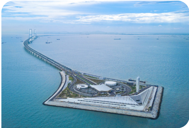
公规院主持勘察设计的国家重大工程——深中通道正式开通
