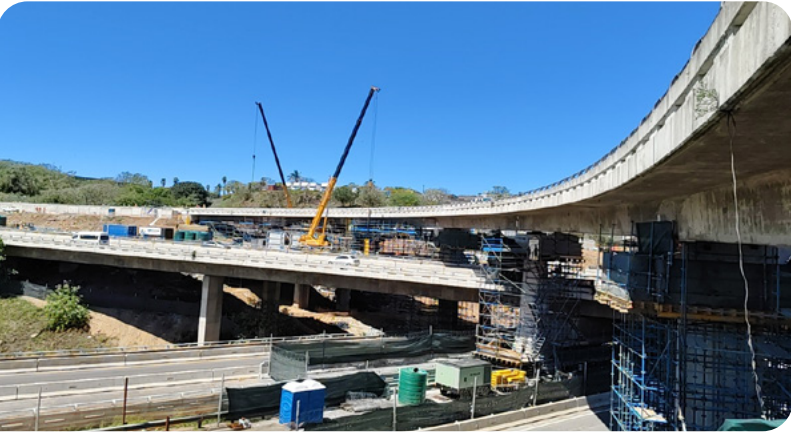
二公院完成南非两座桥梁顶升技术服务项目，得到南非国家道路局的高度肯定
