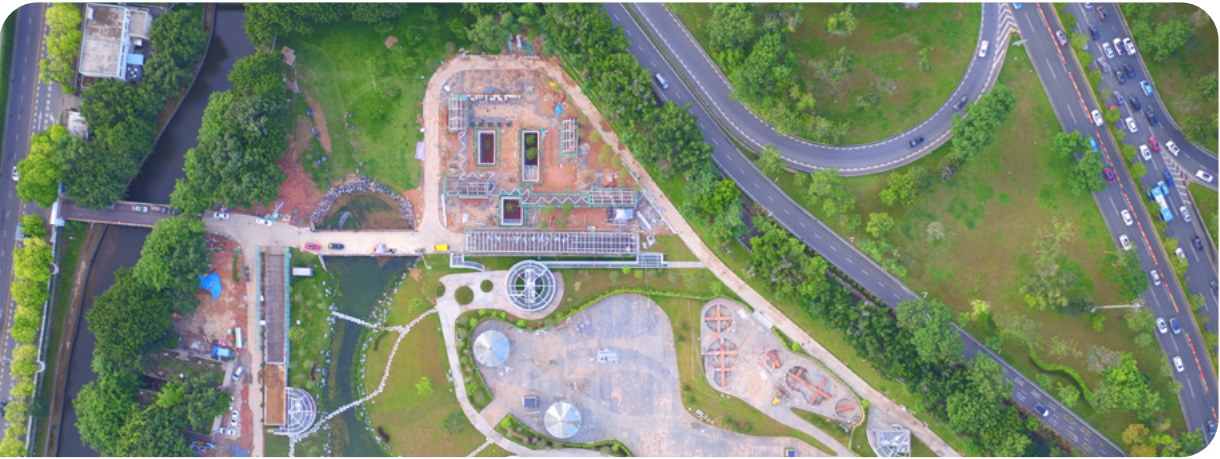
西南院承担设计的深圳市洪湖水质净化厂一期工程“深圳荷水文化科普基地”获得2024年度全球卓越项目管理大奖（银奖），是中国水务行业迄今为止第一个获IPMA奖的项目
