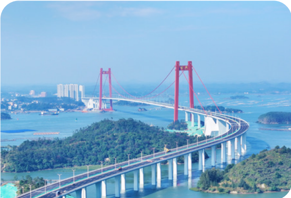
公规院主持设计的广西首座单跨超千米的跨海大桥——龙门大桥顺利通车
