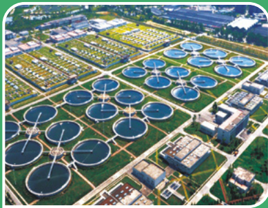
成都市第九再生水厂
