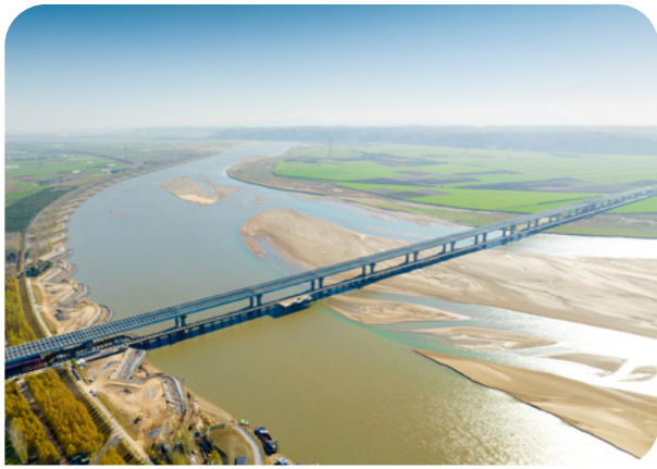
一公院设计的沁伊高速公路黄河特大桥主桥顺利合龙并通过验收
