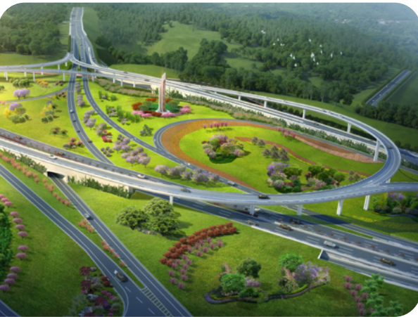
西南院设计牵头的总承包项目、重庆市重点工程——万州青杠磅综合枢纽工程正式竣工通车
