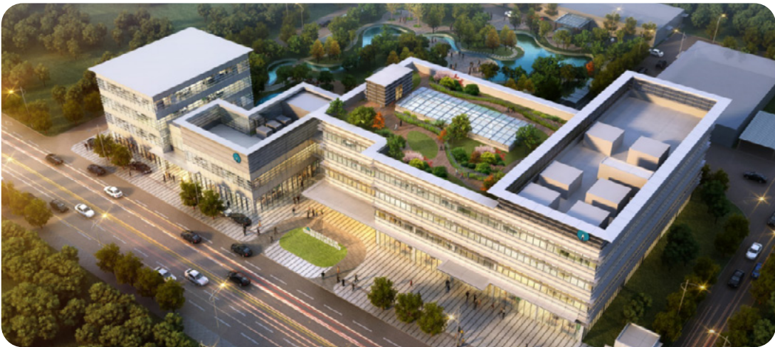
宜兴港华新调度中心大楼天然气分布式能源站项目
