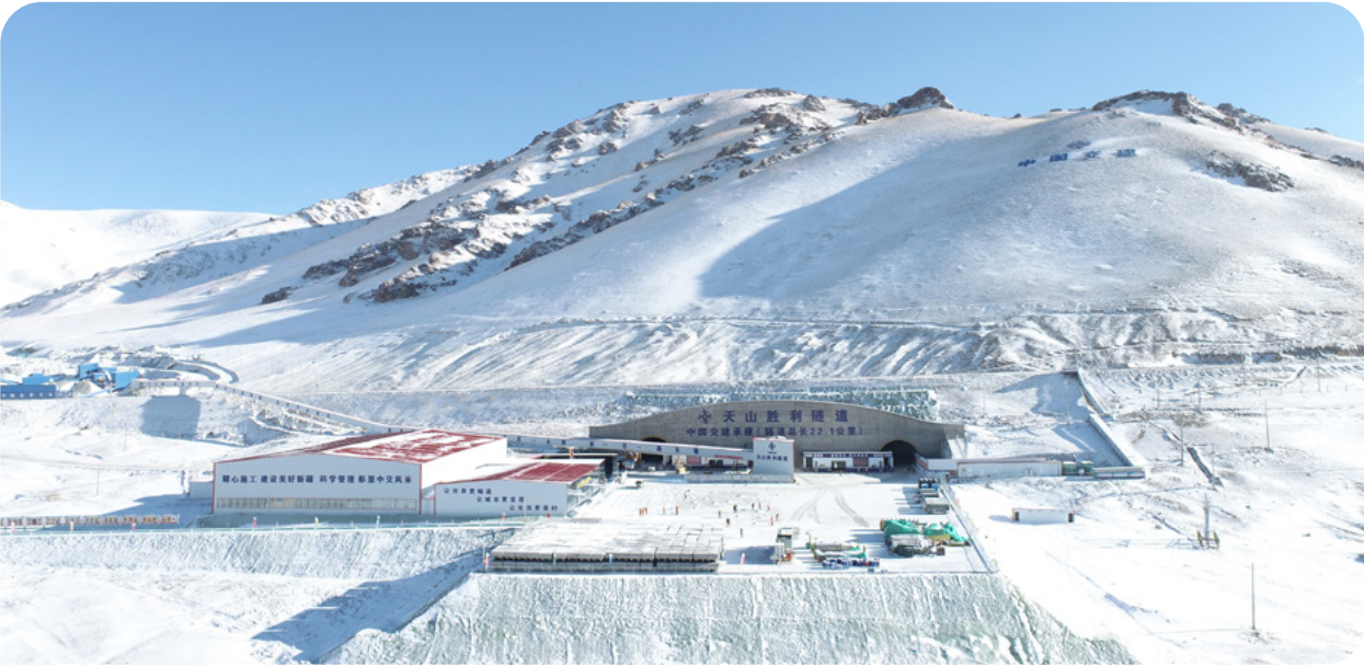
二公院设计的世界最长高速公路隧道——天山胜利隧道全线贯通
