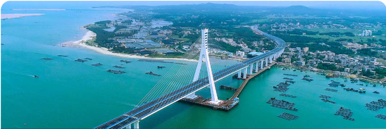
第二十届中国土木工程詹天佑奖——海南铺前大桥（海文大桥）工程
