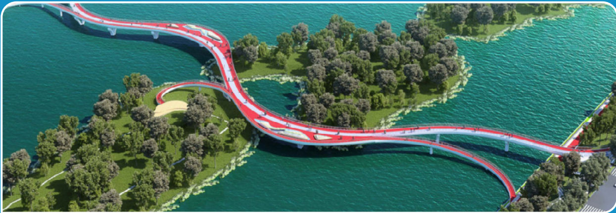
一公院西安浐灞生态区数字经济园区基础设施及配套一期项目市政工程总承包（EPC）项目（三标段）荣获2024年度市政工程最高质量水平评价
