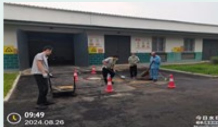
图：人员进行现场清理
