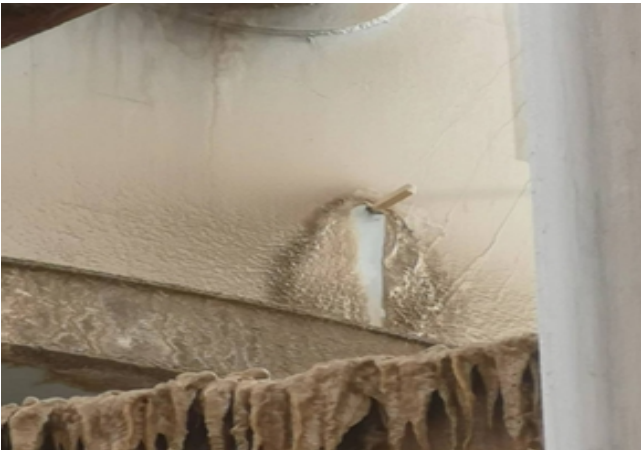
脱硫塔塔壁渗漏整改
