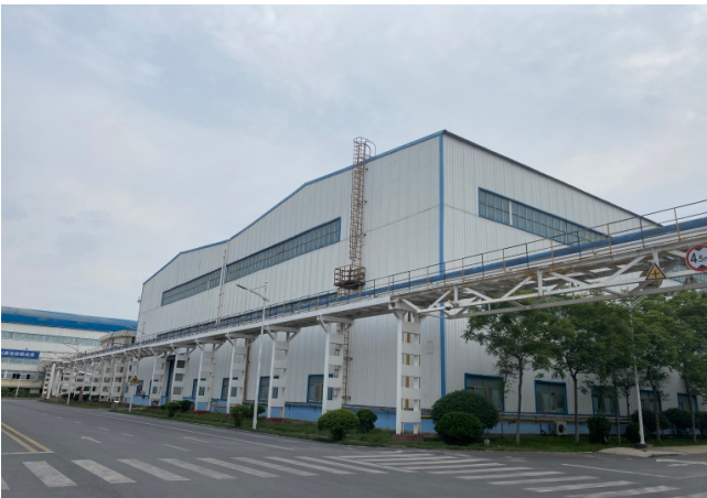
厂区物料输送管网隐患排查
