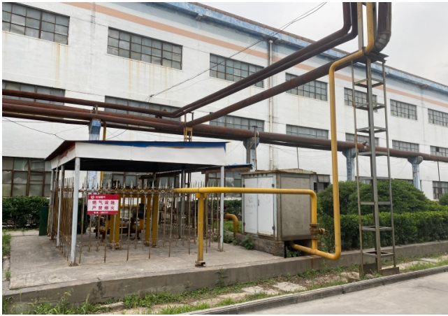
天然气管道隐患排查
