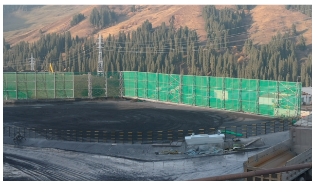
选矿厂原矿堆场防风抑尘网
