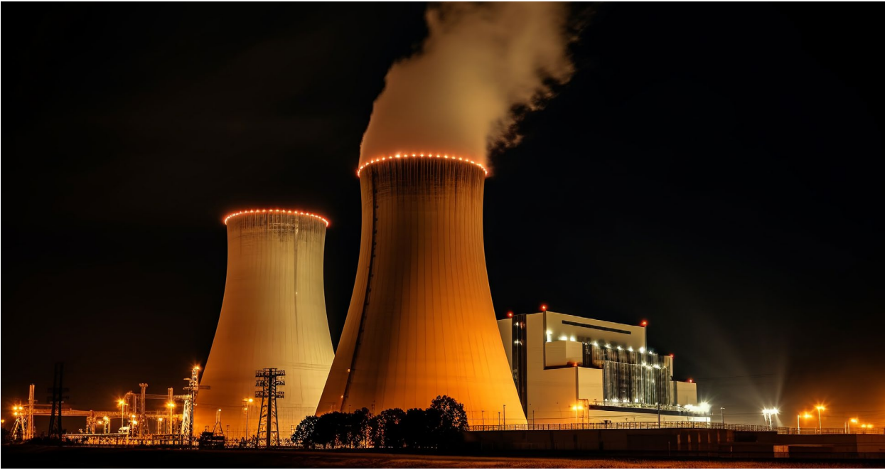
良信股份为商用第 4 代核电站国核压水堆示范工程（装机容量 3000MW）提供了二段式、三段式的直流小断及塑壳产品，应用于升压站、除盐水、循环水泵房等系统
