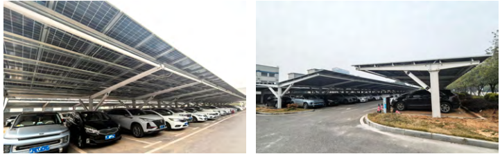
职工停车场加装光伏遮阳棚
