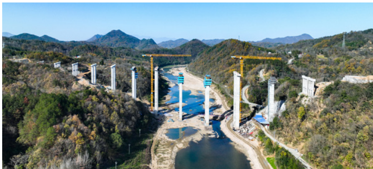
本行安徽分行参与银团贷款支持某大桥建设。
