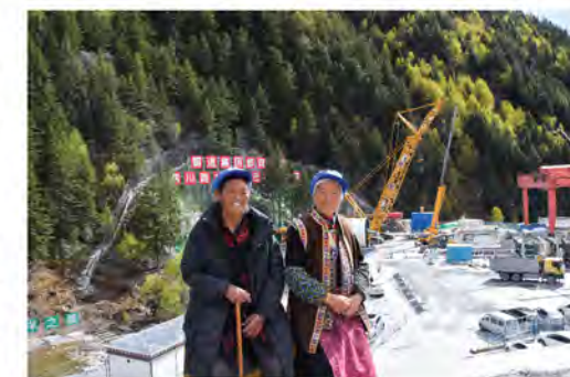
公司所属中铁工服巴朗山项目建设如火如荼 当地群众来到项目现场，满怀期待地询问项目建设情况 该项目将改善川西高原出行条件，推动当地经济快速发展，造福千家万户
