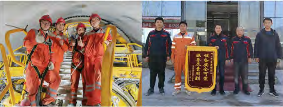
2024年9月9日，采用公司所属中铁装备研制的国产首台大直径大倾角斜井TBM“永宁号”施工的洛宁抽水蓄能斜井建设全线贯通。为保障进度，技术团队将办公室搬到了项目部，服务工程师“全天候全方位”提供技术服务，同时积极收集客户反馈和需求，并共同开发共有知识产权，项目完成专利申报40项，已授权30项，发表核心论文8篇。
