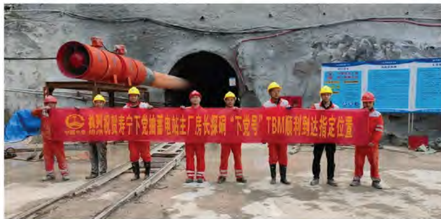
2024年12月18日，“下党号”TBM在福建寿宁下党抽水蓄能电站主厂房探洞工程顺利掘进至设计位置，圆满完成掘进任务
