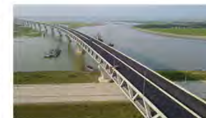
公司承担了帕德玛大桥全部桥梁钢结构的生产制造任务 项目于2024年6月30日完工
