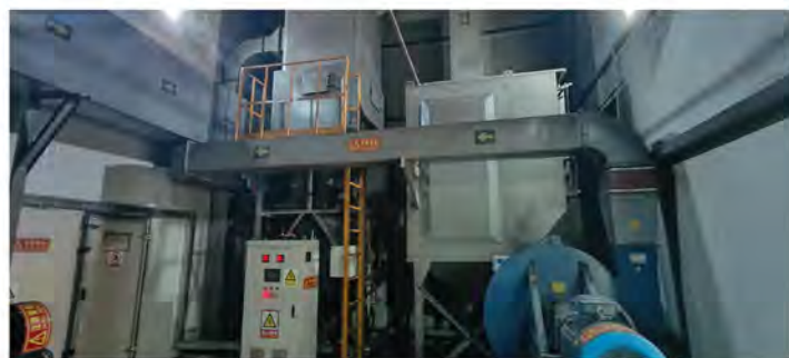
在喷砂工艺环节安装滤筒式除尘设备
