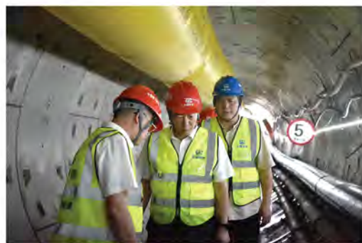
2024年8月7日，中铁工业党委书记、董事长张威深入公司所属中铁工服都江堰供水项目施工现场开展安全大检查
