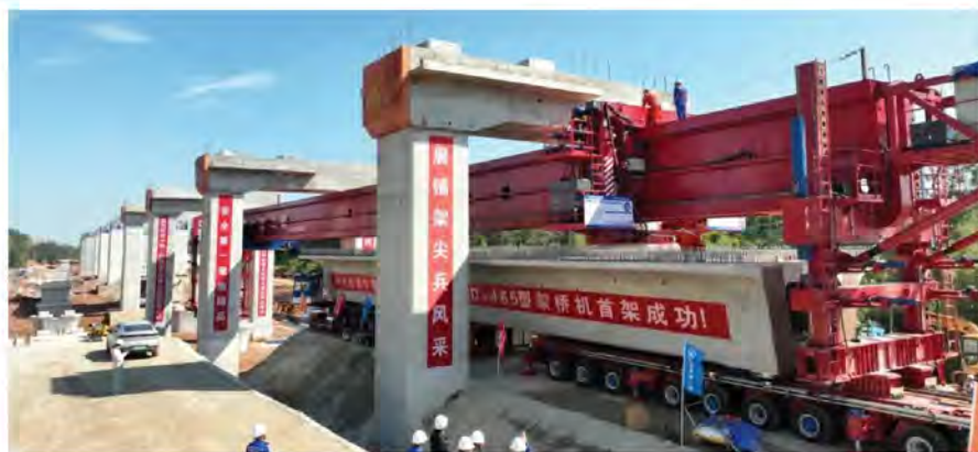
公司所属中铁科工研制的全球首台千吨级多模式新能源架桥机“应龙号”在广东珠肇高铁江机段JJZQ-8标首架成功
