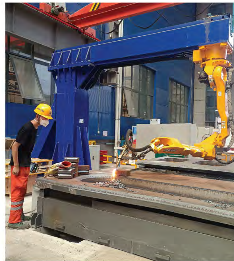
公司所属中铁装备安装的智能坡口切割机器人
