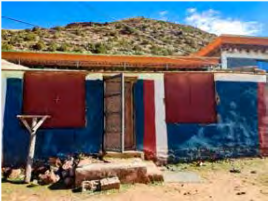
◇ 已安装加固铁皮门窗的房屋
