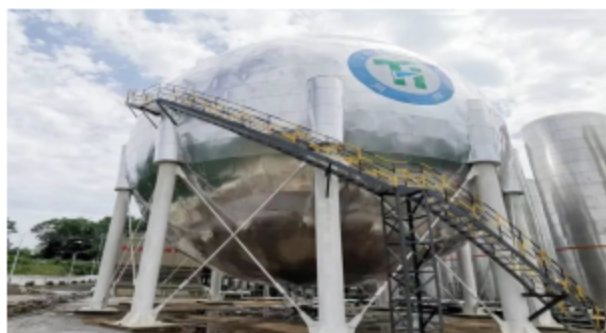
公司承制的开阳同辉气体有限公司年产20万吨食品级二氧化碳项目07MnNiMoDR钢制3000m 3 液态CO 2 球罐
