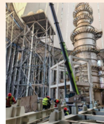
碳捕集装置再生塔的安装
