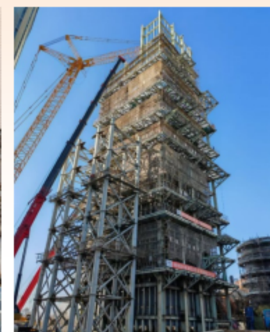
碳捕集装置复合吸收塔的安装
