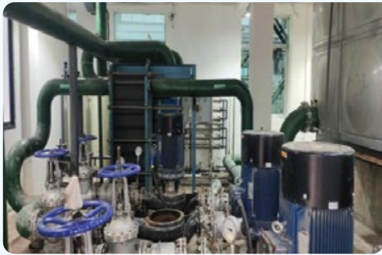
中国航发红林真空炉冷却循环水系统节能保压改造工作
