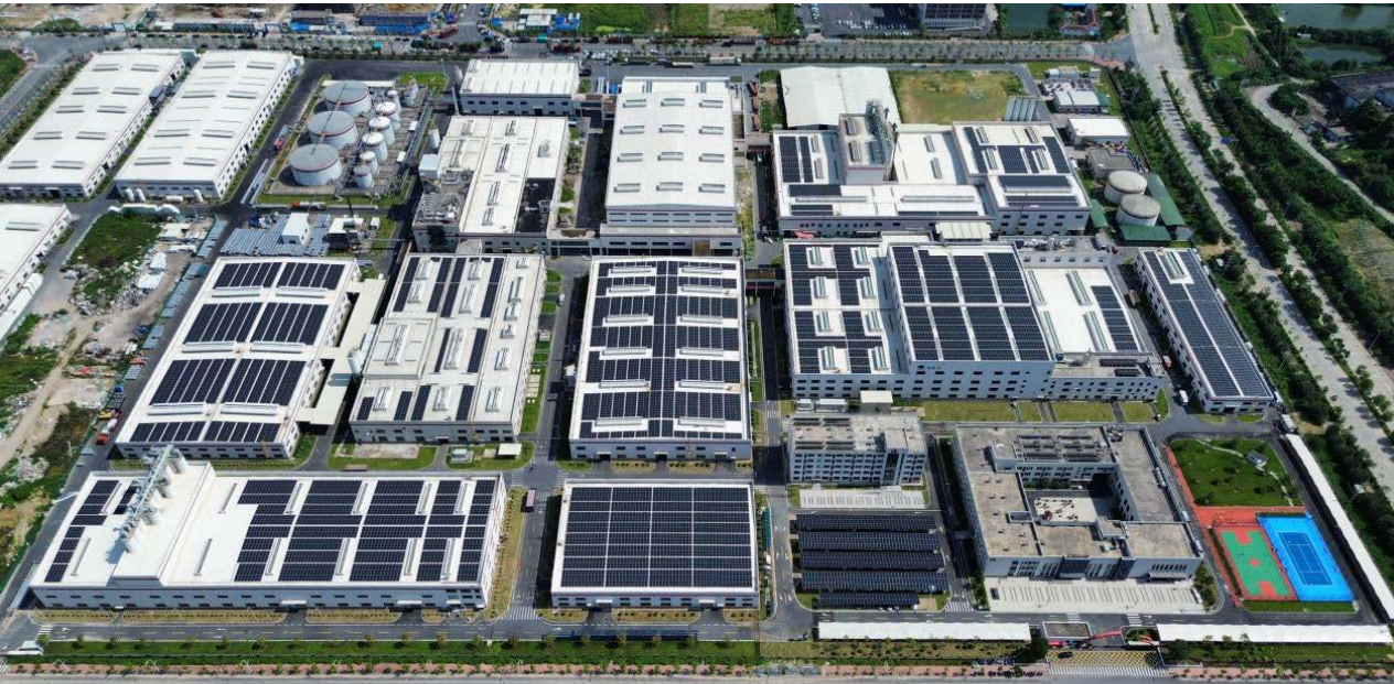
广州智都新能源屋顶分布式光伏项目
