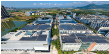
光伏建设情况
