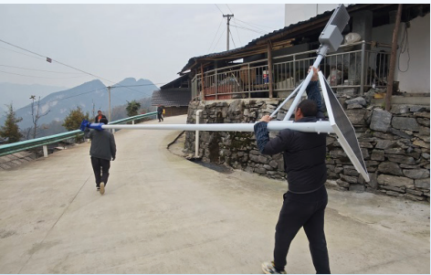
投入帮扶资金开展道路亮化工程等项目
