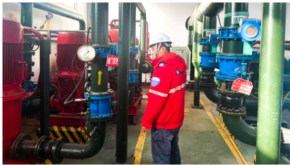
消防设施专项检查
