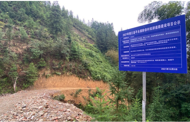
持续 4 年帮扶贵州省黔东南州阶你村修建 5 条机耕道
