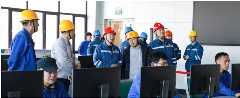
国家电投本溪热电分公司团员青年在远程运维监控室参观
