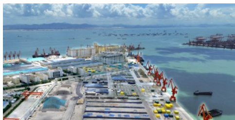
南沙港区四期工程（二期）通过竣工验收
