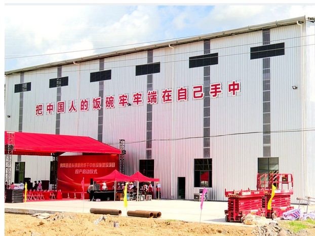
佛冈县迳头镇粮食烘干中心设施建设项目投产启动仪式
