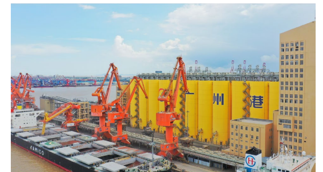
广州港南沙粮食通用码头扩建工程竣工验收
