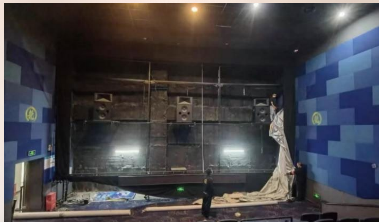
技术部开展日常维修
